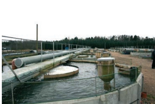
Obr. 8. Kruhové nádrže využívající airliftu (Dánsko) (foto: J. Mareš).
