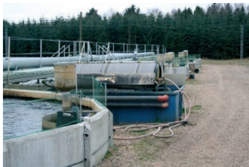
Obr. 8. Kruhové nádrže využívající airliftu (Dánsko) (foto: J. Mareš).
