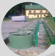
KRUHOVÉ ODCHOVNÉ NÁDRŽE
