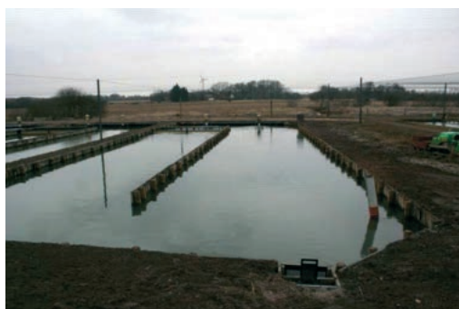
Obr. 10. Nádrže s dělicí stěnou a sedimentačními kužely (Dánsko 1–3, Pravíkov vpravo dole) (foto: J. Mareš).
