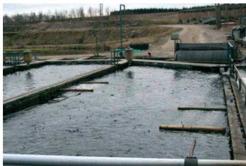
Obr. 11. Umístění podélných airliftů do nádrží (Dánsko) (foto: J. Mareš).
