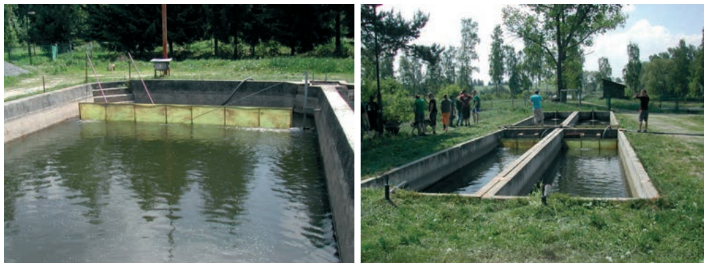
Obr. 9. Vložený airlift se stěnou v běžných nádržích (Velká Losenice) (foto: J. Mareš).
