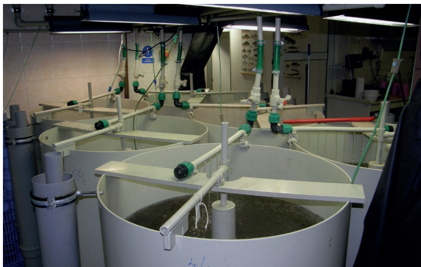
Obr. 23. Recirkulační akvakulturní systém využívaný při intenzivním odchovu štiky obecné ( Esox lucius L.) do stadia rychleného plůdku (foto T. Policar).
