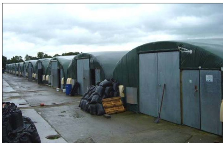
Obr. 4: Lehké stavby (dvě vrstvy folie, jedna vrstva izolační minerální vlny) sloužící pro intenzivní chov okouna říčního v Irsku (Clune Fisheries Ltd.).
