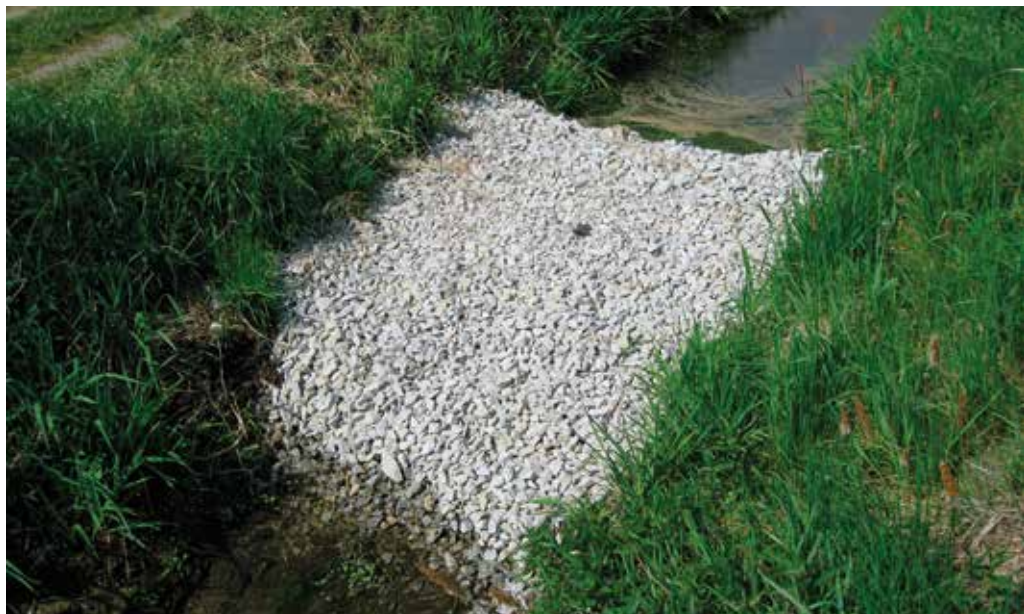
Obr. 3.10. Jednoduchý štěrkový filtr na stoce k zamezení vniknutí dravých ryb (foto J. Regenda).
