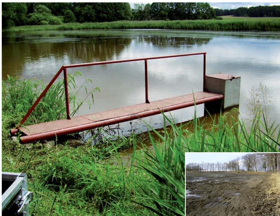
Rybník Rahovec Horní (k. ú. Třebín-Dubné) po odbahnění a revitalizaci (výměna výpustního zařízení) s bohatým litorálním pásmem rákosin (z titulu OP MŽP - zlepšování vodohospodářské infrastruktury a snižování rizika povodní r. 2005-2006) (foto P. Hartman)
