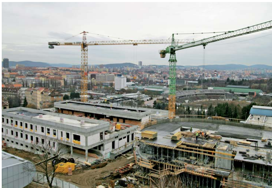
Pokračující výstavba Mendelova pavilonu (prosinec 2011)
