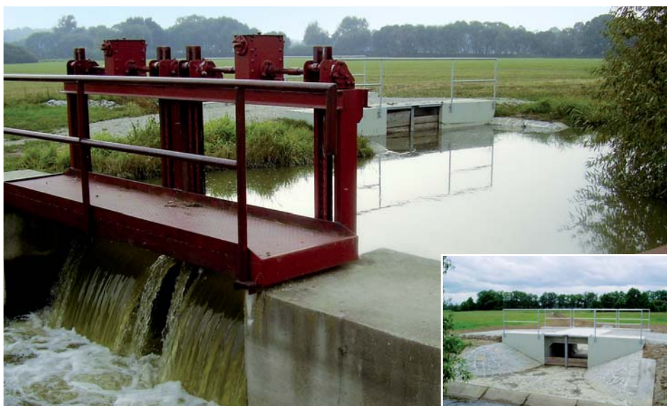
Dehtářský potok vyhrazený novým dvoutabulovým splavem k dělení vody vpravo do stoky Siloe pro přírodní rezervaci Vrbenské rybníky a vlevo pro rybník Čejkovický a Dasenský. Dělicí objekt a stavidlo byly budovány pomocí finanční podpory z protipovodňových opatření KÚ pro Jihočeský kraj a Magistrátu města České Budějovice, rok 2005 (foto archiv Lesy a rybníky města Českých Budějovic s.r.o.)
