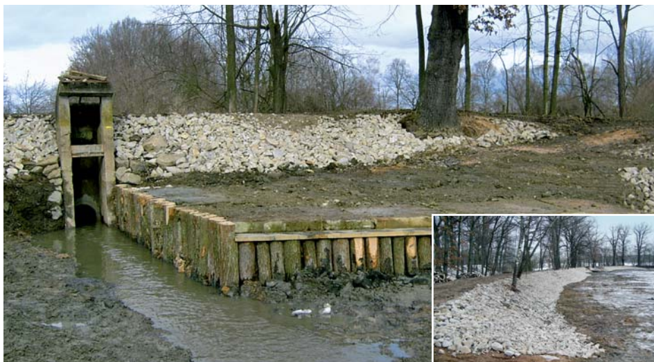
Rybník Ryšávek (k. ú. Třebín-Dubné) po odbahnění z dotačního titulu 129 130 MZe ČR, oprava kádíště, výpustní roury vyložkováním a opevnění návodní strany hráze, údržba trvalé vegetace v r. 2006 (foto P. Hartman)
