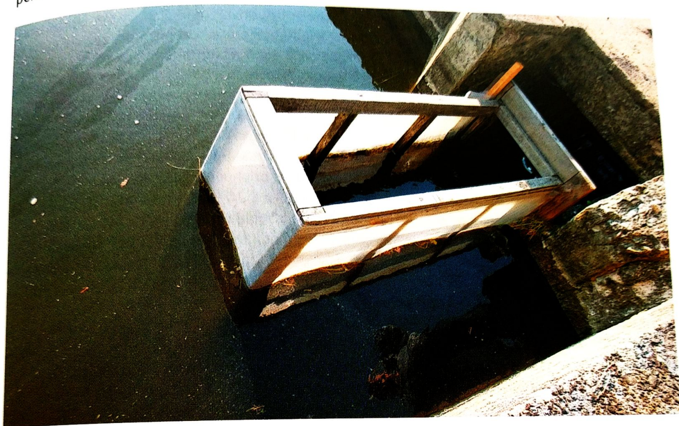
Obr. 3.5. Zvětšení cedící plochy vody pomocí sít na požeráku při odchovu Ma_0/Pe_0 na sádkách (foto J. Regenda).
