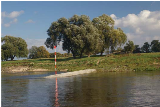
Foto 3. Ukáзка koncepčního výhonu v německém úseku řeky Labe
