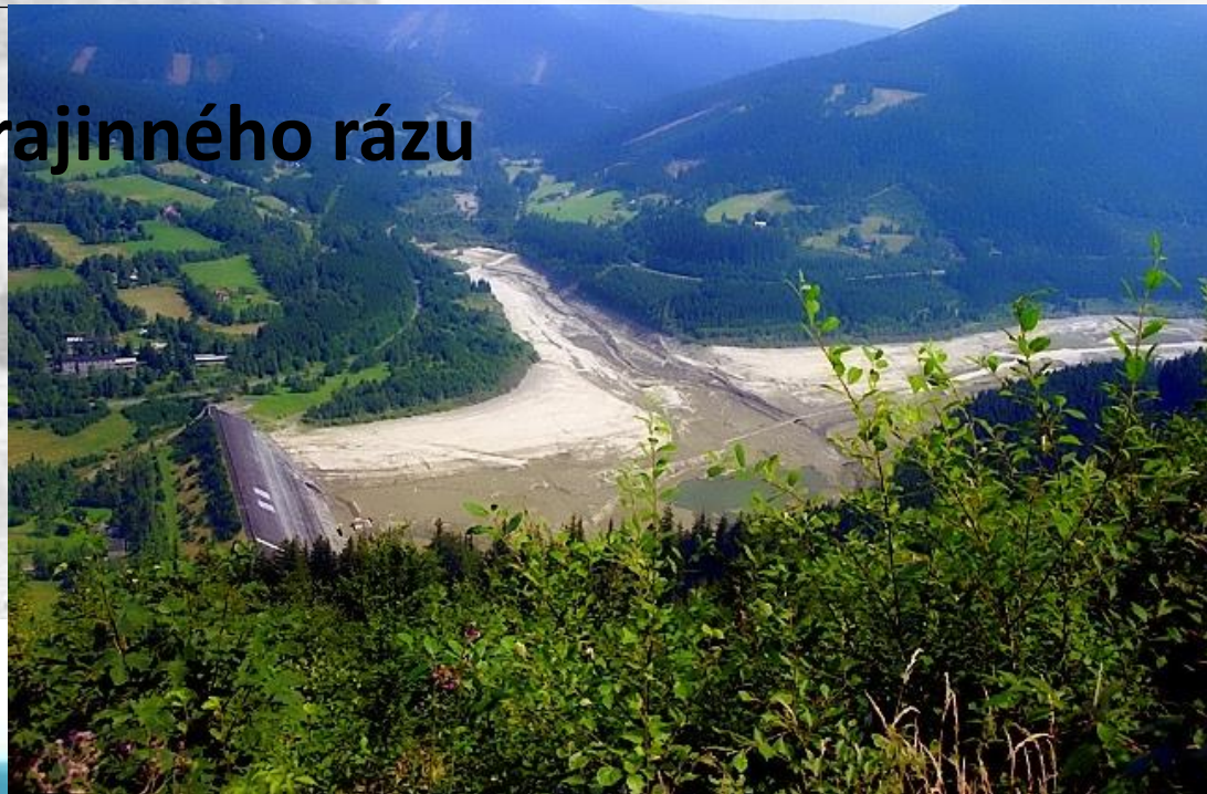
Beskydy přehrada Morávka
